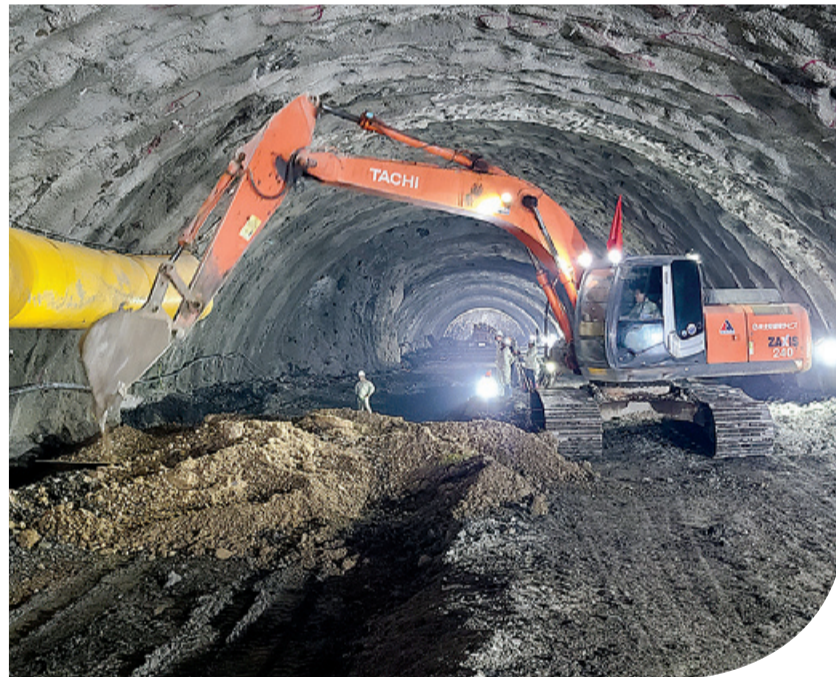
Thi công hầm Tuy An trên tuyến cao tốc Bắc - Nam giai đoạn 2
