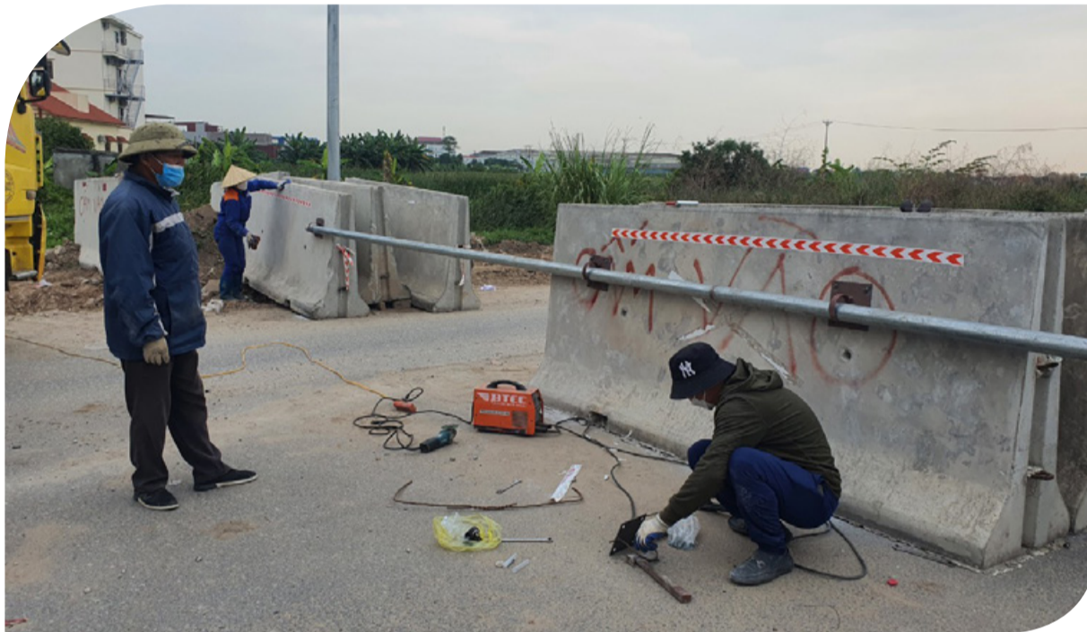
Công nhân hàn rào chắn để ngăn người dân đi vào tuyến đường ven biển
