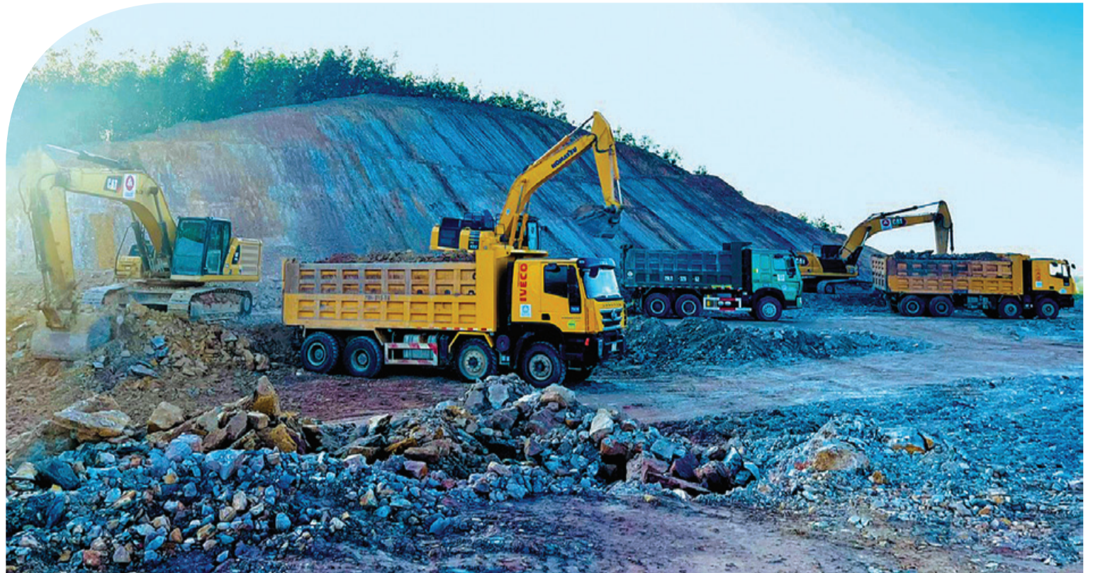
Thi công cao tốc Bắc - Nam đoạn Vũng Áng - Bùng
