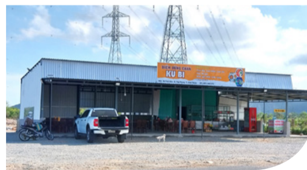
Điểm dừng chân KuBi nằm ngay dưới đường điện cao thế, tiềm ẩn nguy cơ phóng điện, cháy nổ
