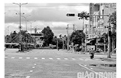
Đèn tín hiệu giao thông được lắp đặt trên đường Phan Văn Trị, huyện Phong Điền
