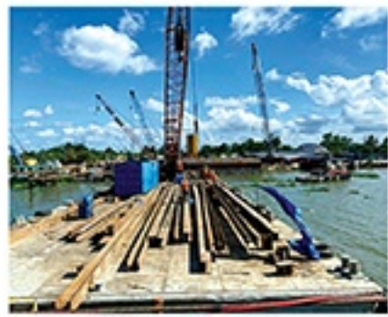
Thi công cầu Mỹ Thuận 2
