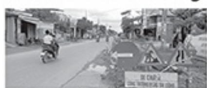
Biển báo, rào chắn được lắp đặt tại các vị trí thi công công trình
