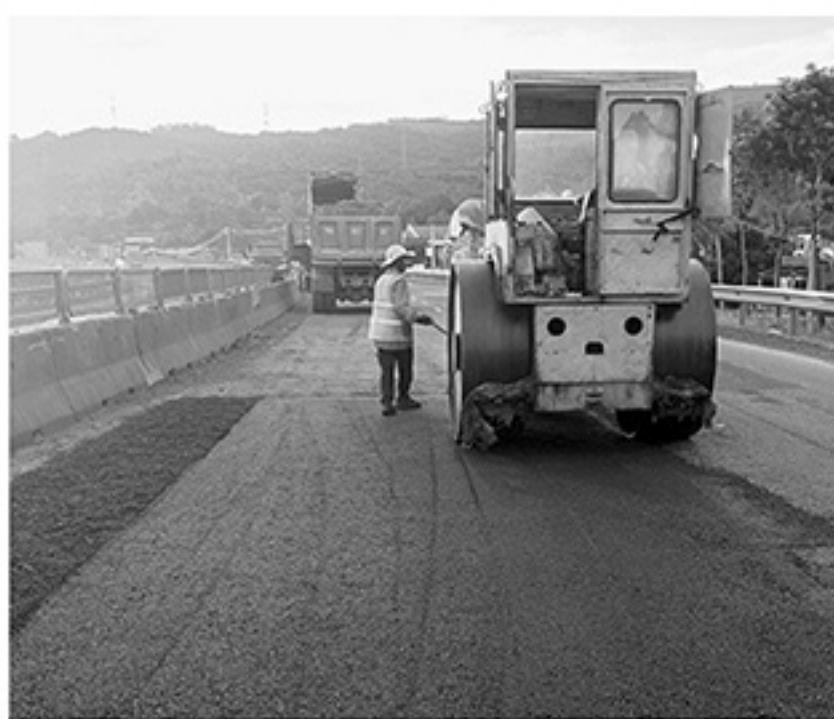
Công ty CP Quản lý sửa chữa đường bộ Phú Yên tăng cường hơn chục mũi sửa chữa triệt để hư hỏng QL1 Phú Yên
