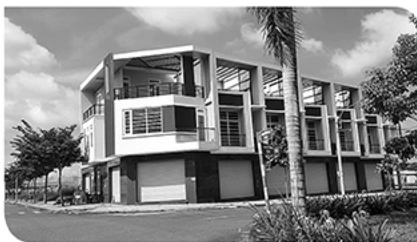
Nhiều căn nhà khang trang, xây dựng kiên cố tại dự án D2D nằm ngay mặt tiền TL769 dù đã hoàn thiện nhiều năm nhưng không có người ở
