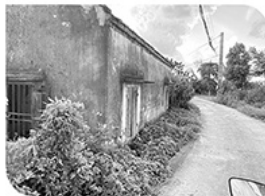
Không ít công trình xây dựng của người dân vi phạm hành lang đê Diên Công
