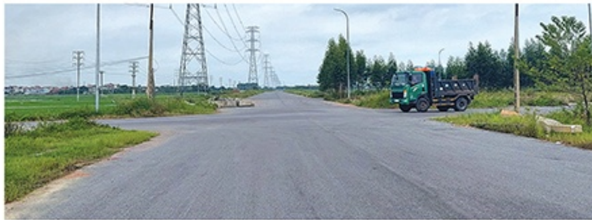
Tuyến ĐH5B, đoạn qua xã Tư Mại, huyện Yên Dũng đã hoàn thành thi công mặt đường bê tông nhựa
